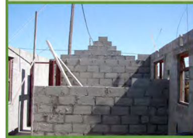
Foto 9: Die Innenwände entstehen
