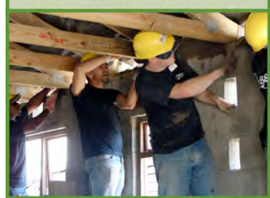
Foto 12: Isolation des Daches
