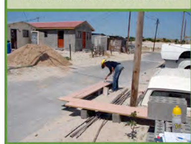
Foto 6: Grundieren des Giebels
