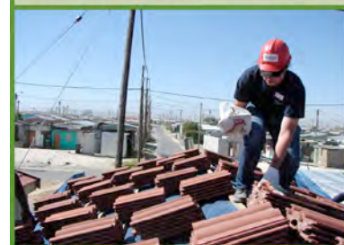
Foto 11: Die ersten Dachziegel
