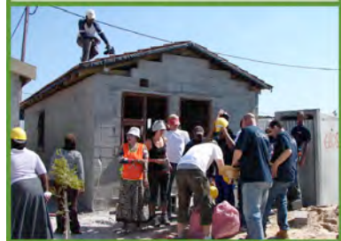
Foto 13: Fast fertiges Haus
